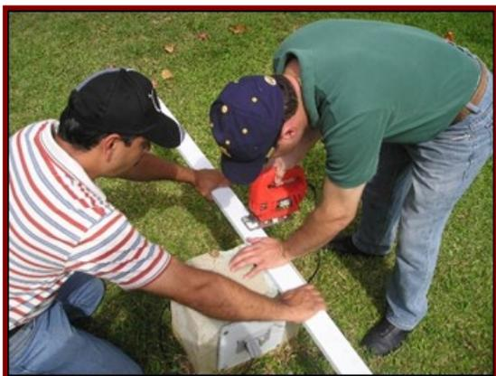
de recolección. Más o menos a una distancia de 1" de este orificio, delinee con un sobre manila corto lo que pasará a ser la tapa del tanque. Por aquí se harán las aplicaciones de abono, agua y cualquier otra sustancia necesaria. Haga un corte limpio y reutilice la tapa para proteger el tanque. Esta tapa se puede reajustar utilizando un gozne. Haga 2 perforaciones de 1" al lado contrario de donde pasaría a estar el orificio de 3".
